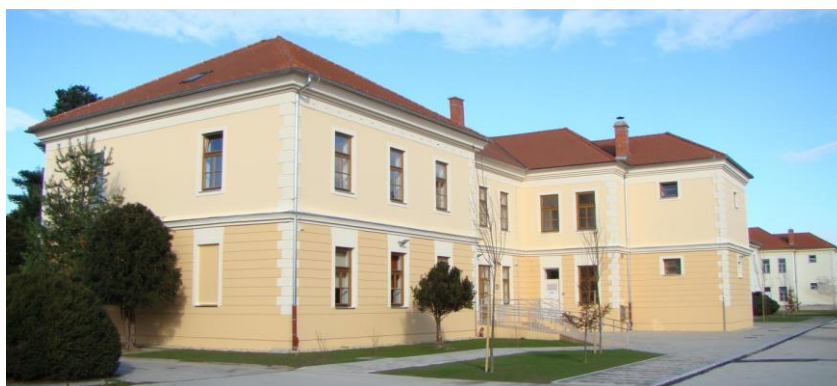
Slika 2. Zgrada TICM 1 (u prvom planu) i TICM 2 (u pozadini)
